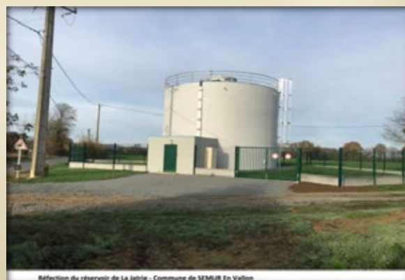
Réfection du réservoir de La Jatrie - Commune de SEMUR En Vallon
